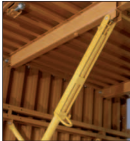
Contrefiche articulée facilitant le décoffrage
