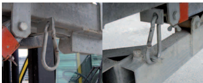
Dispositif de verrouillage au repliage
