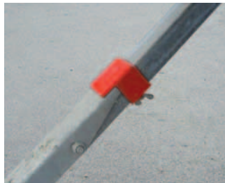
Verrouillage du bracon de ferme
