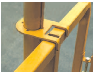
Contrefiches évitant l'emploi d'étais de compression au relevage de grande superposition et verrouillage du réglage (H= 12,20 m)
