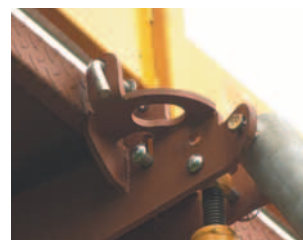
Supports de passerelle adaptés : suppression des supports d'étais et accrochage direct des étais universels
